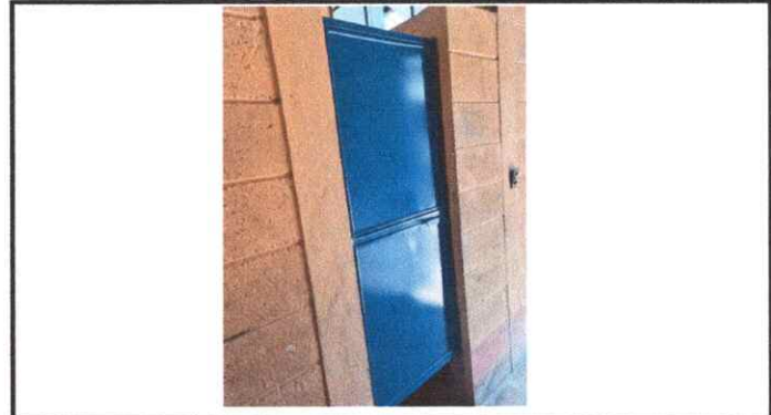
Foto 16: Fabricación e instalación de puerta de metal individual en Baños
