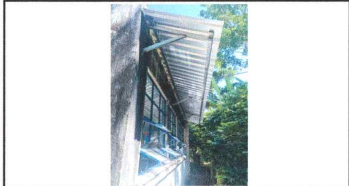
Foto 1: Sustrucción de lamina troquelada por lamina troquelada Aluzinc calibre 26, en Aula
