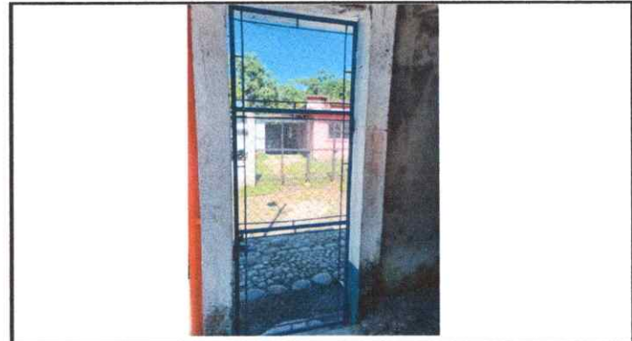
Foto 18: Fabricación e instalación de puerta de metal de ingreso
