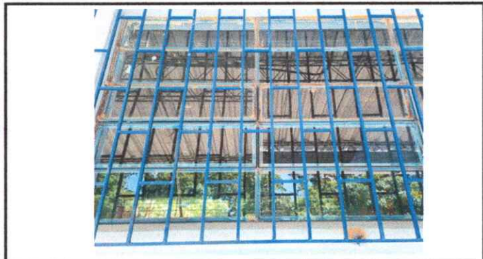
Foto 3: 21.1. Sustrucción de vidrios, en Aula
