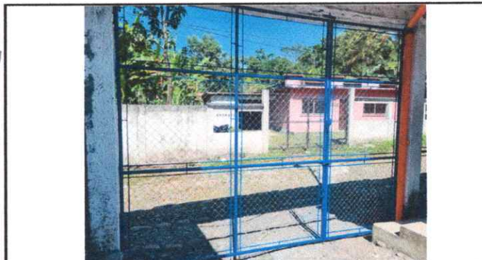
Foto 17: Fabricación e instalación de porton de metal de Ingreso
