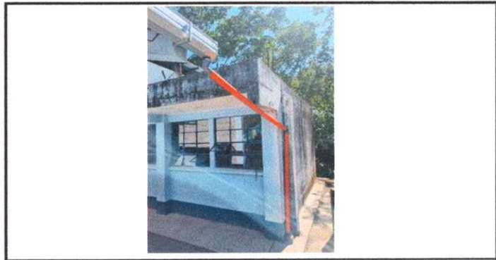
Foto 5: Sustrucción de bajada de agua pluvial de metal por tubo PVC 3" AULAS. Sustrucción de soporte o pescante de metal para canal, en modulo de Aulas
