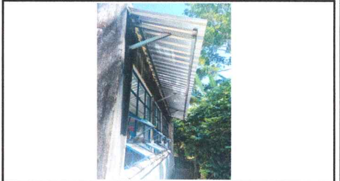
Foto 2: Mantenimiento de estructura de soporte de metal, en Aula
