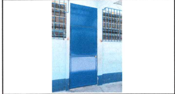
Foto 14: Fabricación e instalación de puerta de metal, en modulo de Aulas
